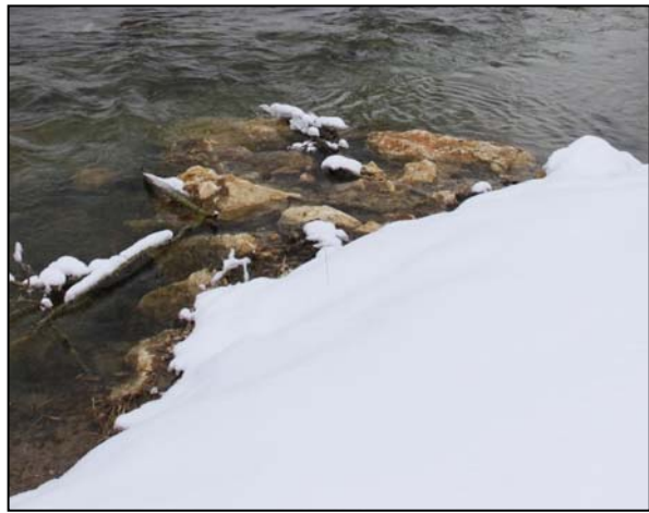
Bild (Gemeinde Wehringen): Einbau von Uferbausteinen
