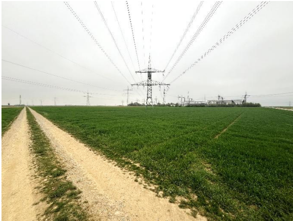
Abbildung 3: Eingriffsbereich und das bestehende Umspannwerk (Blickrichtung Nordosten)
