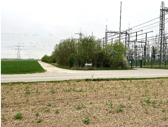
Abbildung 5: Hecke mit CEF-Fläche Zauneidechse, westlich des Umspannwerks, im Vordergrund Ortsverbindungsstraße Oberottmarshausen-Wehringen (Blickrichtung Nord)
