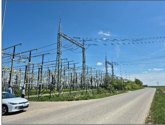
Abbildung 25: Blick vom Geltungsbereich auf das benachbarte Umspannwerk der Amprion GmbH
