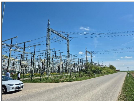
Abbildung 19: Blick vom Geltungsbereich auf das benachbarte Umspannwerk der Amprion GmbH
